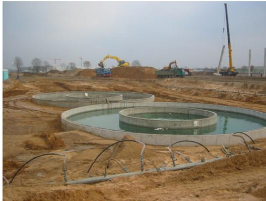
*Mit Wasser gefüllte Sprinklertanks für Lagerhallen in der Bauphase-selbst für diese wird schon so vorgesorgt, dass Wasser vorhanden ist!*
